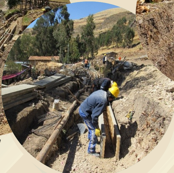
Mano de obra calificada del proyecto realizando el encofrado del canal de riego
