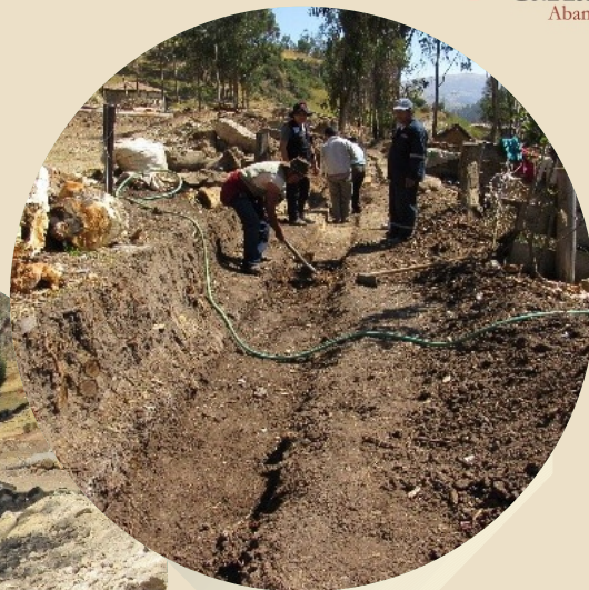
Monitoreo y seguimiento del equipo técnico de la oficina de Cáritas en la ejecución de obra
