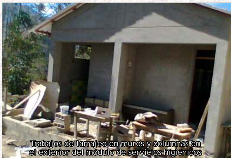
Construcción del módulo de SSHH del Centro Educativo N° 54085 de Huancarama
